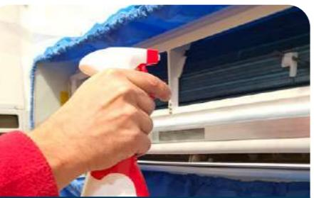
Pulizia batteria senza telo di protezione
