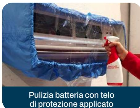
Pulizia batteria con telo di protezione applicato
