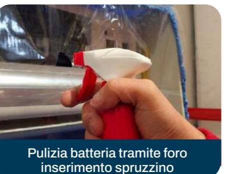
Pulizia batteria tramite foro inserimento spruzzino
