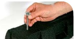
Fissaggio diretto della vite sul supporto
